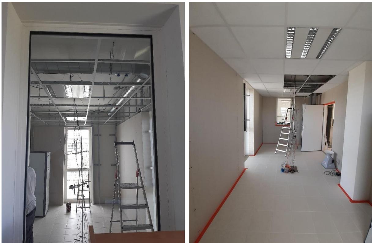
Figure 17 : Préparation de la chambre test avec une finition intérieur en plaques de plâtre (à gauche) et peinture blanche de finition (à droite).
